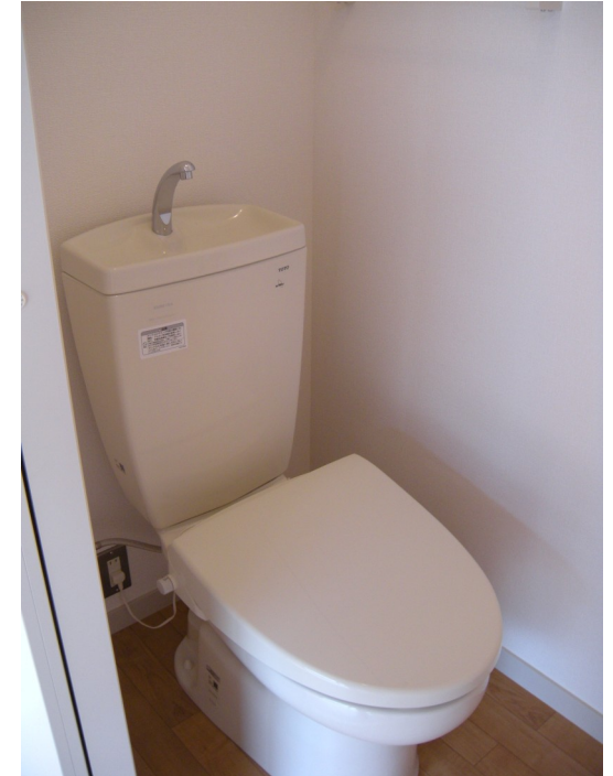
トイレ新設 (ウォームレット)
